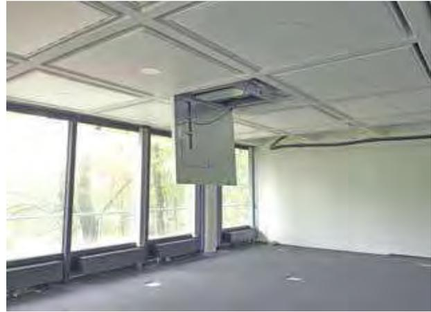
Eine saubere Montage sowie eine einfache Reinigung und Wartung ermöglicht das Klappscharnier, mit dem das Segel leicht geöffnet werden kann
