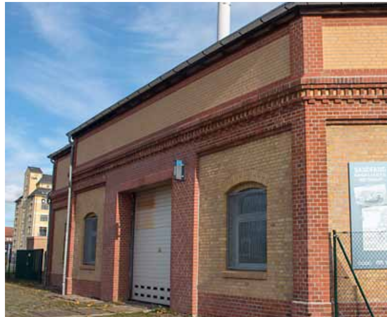
Der Sandfang im Magdeburger Wissenschaftshafen, dem einstigen Handlungsort, ist wichtiger Knotenpunkt des Magdeburger Abwassersystems.
