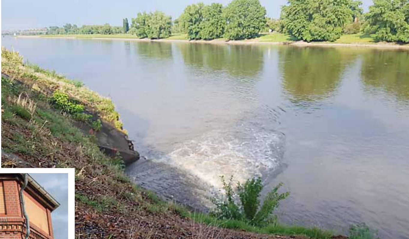
Das Foto zeigt einen Mischwasserüberlauf nach Starkregen am 17. Mai 2022.
