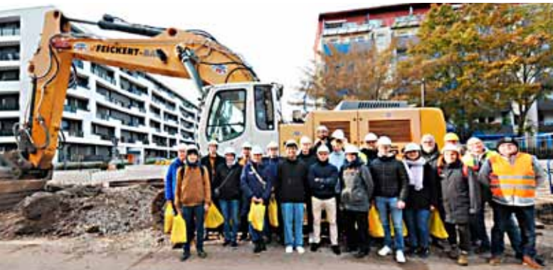
Young Engineers informierten sich auf einer Baustelle über die Kanalsanierung. Foto: Justin Meyer
