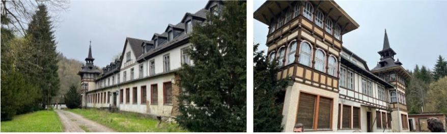
Das Logishaus ist ein zweigeschossiger Fachwerkbau mit pittoresken Ecktürmchen und seit Jahrzehnten ungenutzt. In einem entsprechenden Zustand befindet sich die Bausubstanz, die an vielen Stellen abgängig ist.
