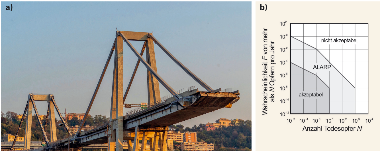
Bild. 1. a) Eingestürzte Autobahnbrücke in Genua, Abb.: Andrea Izzotti/Shutterstock und b) Beispiel einer Nachweiskurve (Groningen-Kurve 1978). Abb.: [5]
