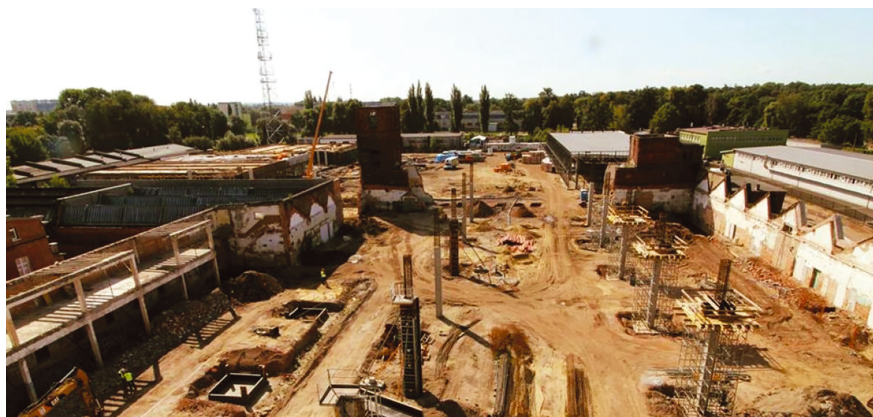
Bild 2. Bauzustand Abb.: Magdalena Kosińska, pabianice.pl, 2018
