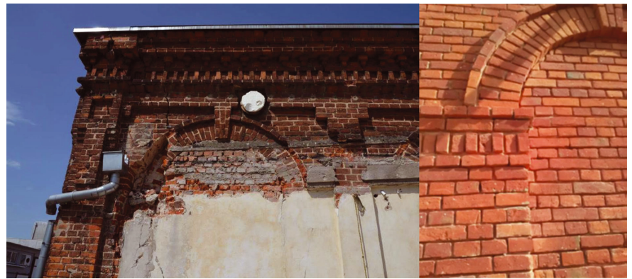
Bild 5. Fassade: Ursprungszustand (links), nach Restaurierung (rechts) Abb.: Eigene Darstellung
