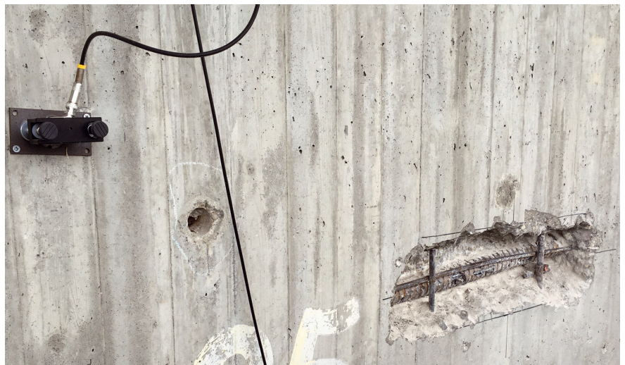
Bild 3. Sensor 1 und Öffnung mit noch geschlossenem Hüllrohr von Versuch 4 Abb.: Bilfinger
