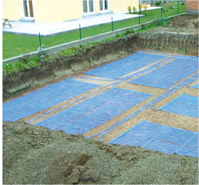
Bild 2: Kapillarrohrmatten-Erdwärmekollektor nach Verlegung im Erdreich. Bild: Institut für Solarenergieforschung ISFH
