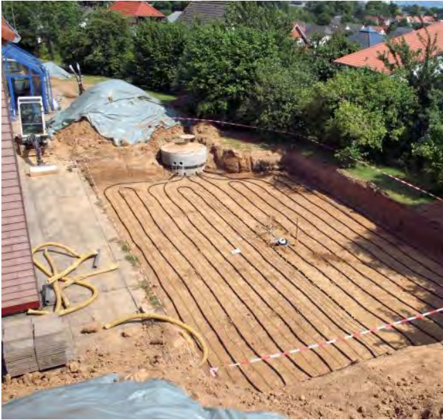
Bild 1: Rohrschlangen-Erdwärmekollektor nach Verlegung im Erdreich. Bild: Erdwärme PLUS
