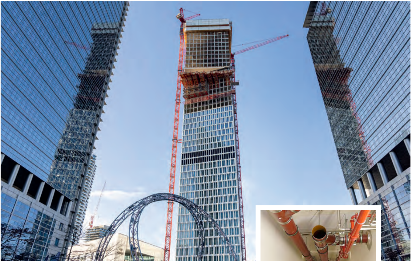
Baustellenbegehung in Frankfurts neuem Vorzeigeprojekt: Das Büro- und Hotelhochhaus One (im Bild oben der Baufortschritt im März 2021) soll eine neue Landmarke werden. Bilder: CA Immo (oben) / Hans-Wilhelm Berghoff (rechts)
