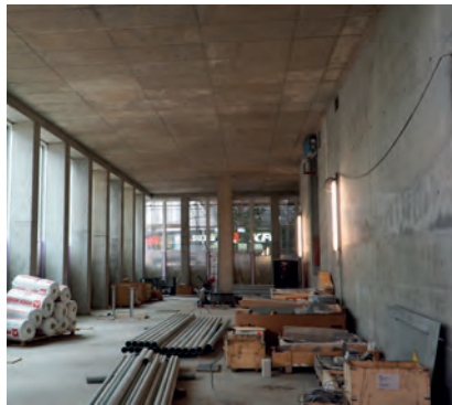
Die Lobby im Erdgeschoss. Bild: Hans-Wilhelm Berghoff
