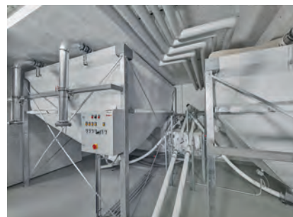
Bild 2: Ein Zwischenbehälter mit Doppelabsaugtopf ermöglicht die Kombination aller Gewebesilos mit den zwei Pelletkesseln. Bild: A.B.S.
