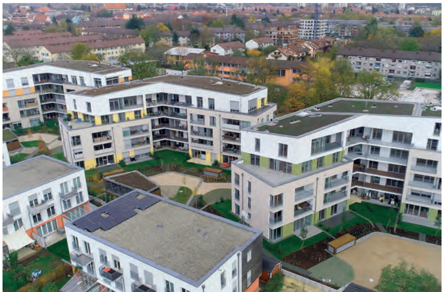
Das Wohnungsbauprojekt „Sonnenhöfe“ in Freiburg: In vier Häusern sind hier insgesamt mehr als 10 000 Quadratmeter Wohnfläche entstanden. Holzpellets werden für die Wärmeversorgung genutzt. Bild: A.B.S.
