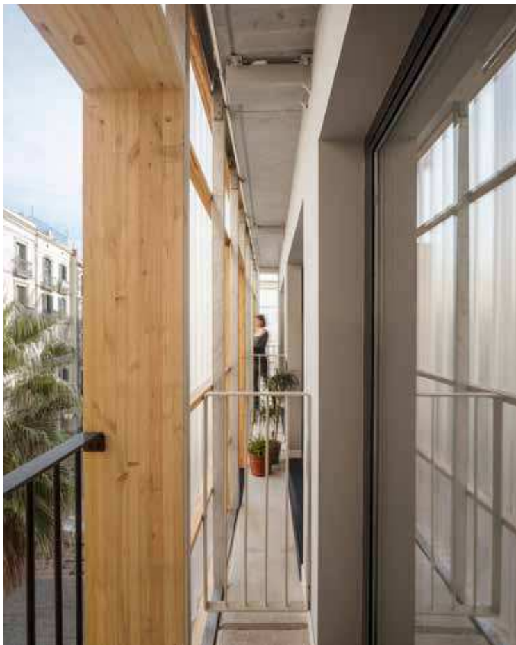
Zwischen der nordwestlichen Fassade aus Polycarbonatplatten und den Containern befindet sich ein Zwischenraum, der als Loggia genutzt wird
