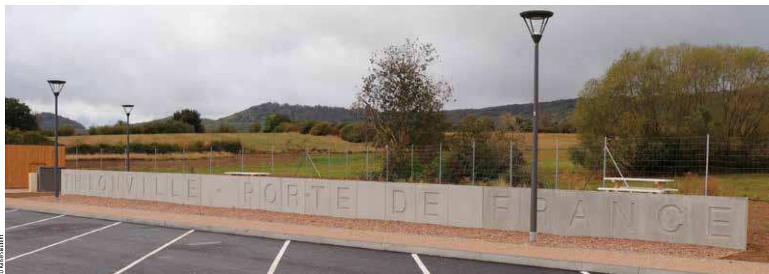
L-Wand in Thionville: Bei der Fertigung der nichttragenden Konstruktion kam 100 %-RC-Beton zum Einsatz
